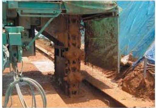
写真3 気泡安定液による地盤掘削状況
